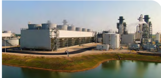
โรงไฟฟ้าก๊าซธรรมชาติ Temple I (Temple I CCGT)
