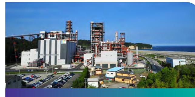
โรงไฟฟ้านาโกโซ (Nakoso IGCC)
