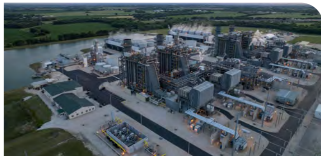
โรงไฟฟ้าก๊าซธรรมชาติ Temple II (Temple II CCGT)
