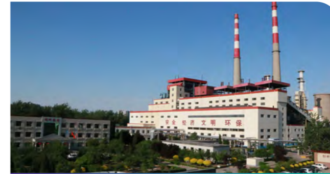
โรงไฟฟ้าพลังงานความร้อนร่วม เจิ้งติ้ง (Zhengding)
